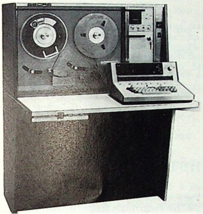
Bild 1. Magnetbandspeicher mit einem Secre-Datenschreiber
